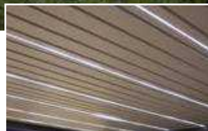
Bandeaux leds intégrés aux lames et sur gouttières périphériques
